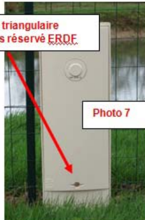
Branchement aéro- souterrain
