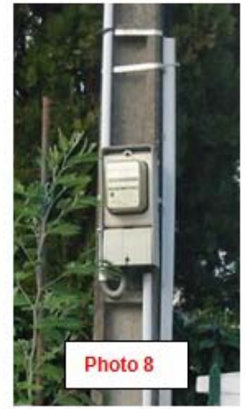
Compteur extérieur apparent
