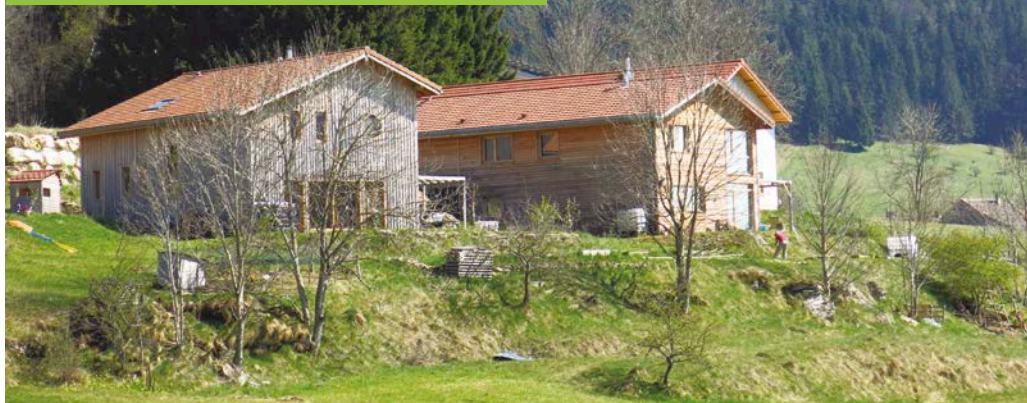
Source : ADIL Information Énergie - Maison bois St Julien-en-Vercors
