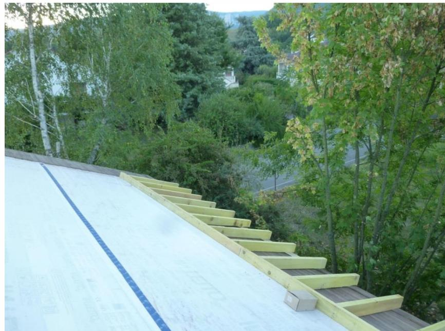
*Isolation de la toiture par l'extérieur (sarking) en panneaux de laine de bois rigides*
