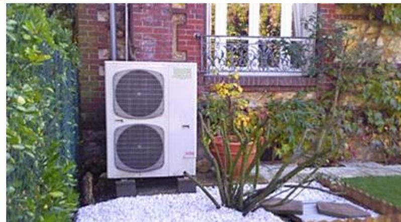
Une pompe à chaleur récupère des calories (énergie) d'une source extérieure (sol du jardin, air environnant ou eau d'une nappe phréatique), pour réchauffer un circuit d'eau utilisé pour le chauffage du logement.
