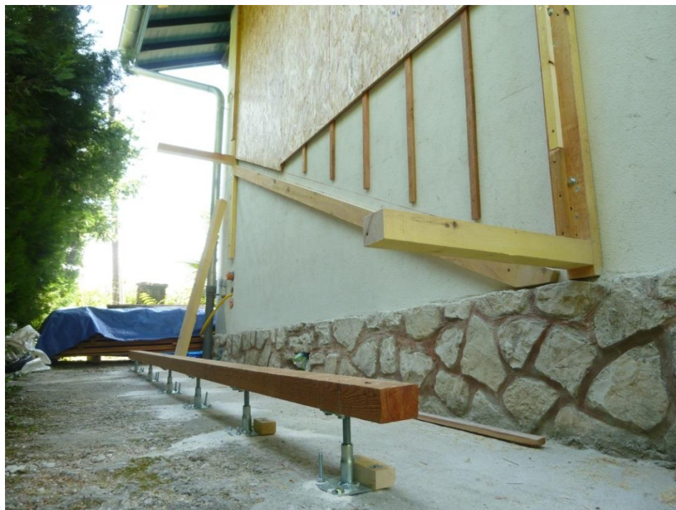
Création d'un silo de stockage des granulés (capacité environ 4300 kg)
